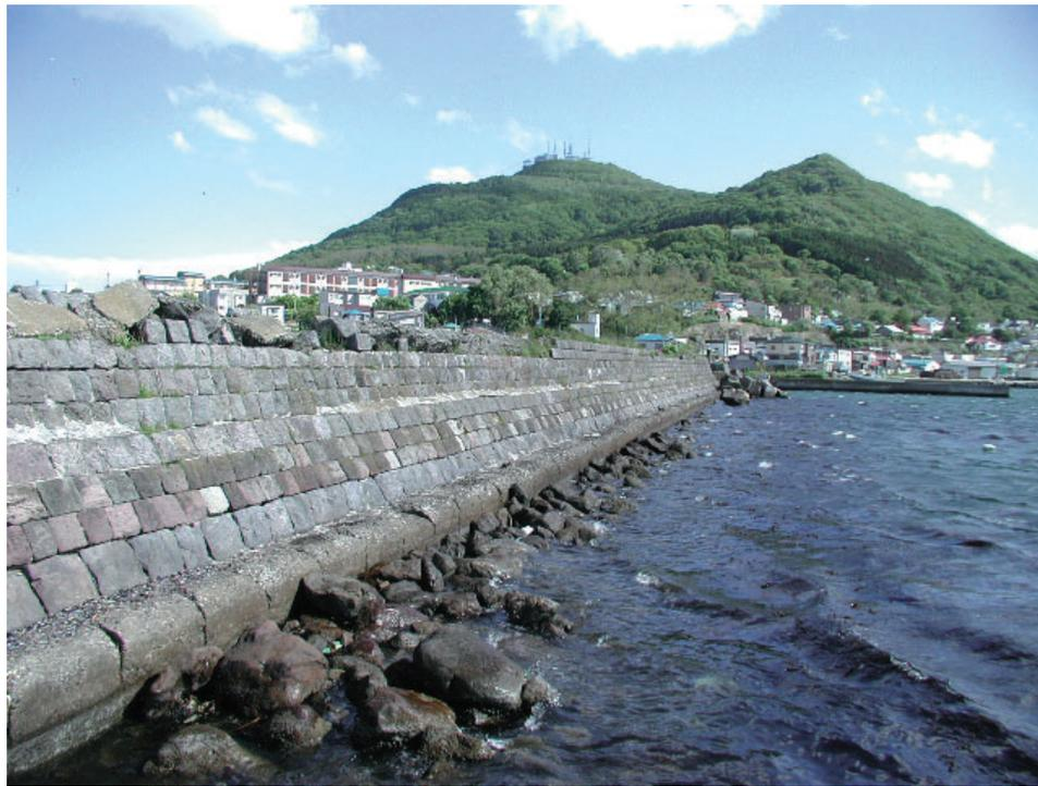
函館漁港には、明治29年に近代土木の父として有名な廣井勇博士が監督技師として着工した石積防波堤が現存している。この防波堤は、博士が建設した防波堤として有名な小樽港の国内初の本格的な外洋防波堤（北防波堤）より1年早く着工したもので、北海道で最初の近代港湾施設といわれている。明治32年に完成し、100年以上経過した現在でも防波堤として機能している現役の港湾構造物で、学術的にも貴重な財産である。なお、この防波堤は、平成16年に土木学会選奨土木遺産に認定されている。
