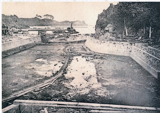
工事中の波切漁港
