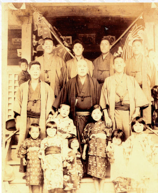
住民センターが建設されたところの 福良猛太郎(橋野氏所蔵)
